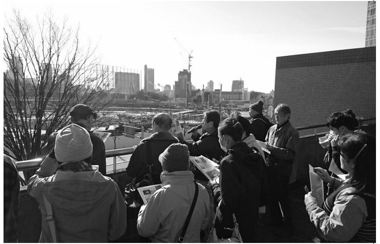
競技施設がとりこわされ掘削作業がおこなわれている 新国立競技場建設現場
