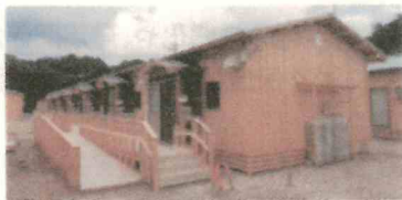
東日本大震災(2011年) 403人の仲間が8団地で584戸を建設
