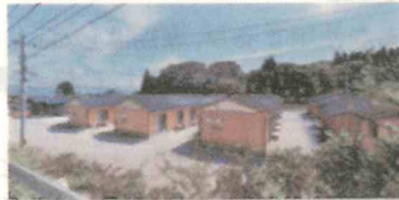
熊本地震(2016年) 448人の仲間が29団地で563戸を建設
